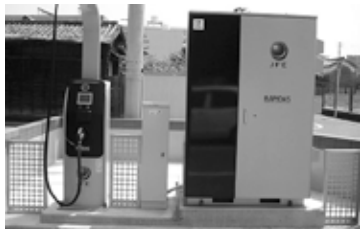
電気自動車充電設備 (写真は徳島保健所庁舎)
