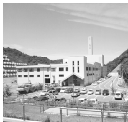
鳴門市クリーンセンター
