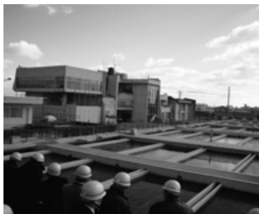
老朽化が進む浄水場施設
