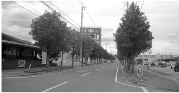
南浜黒崎線(黒崎バイパス)
