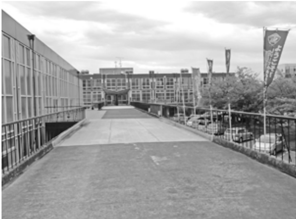
築50年を経過した本庁舎
